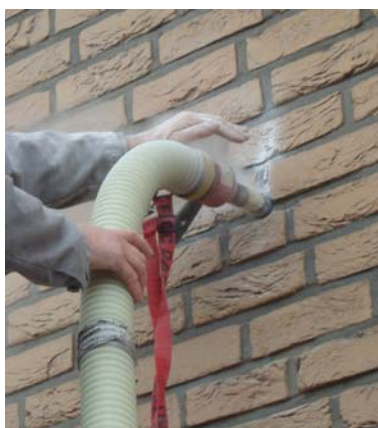
Einblasen von Perlite in eine Hohl-schicht
