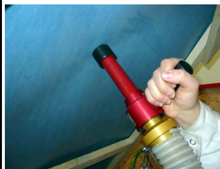
Einblasen eines Dachfensterfutters
